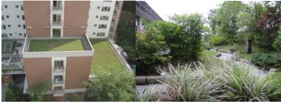
屋頂隔熱系統(左：宿舍大樓、右：設計大樓)
