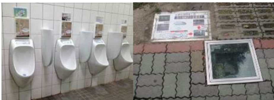
免水小便斗與透水鋪面
